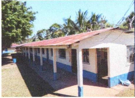
Foto1: Se observa del techo muy deteriorado en oxidado de las laminas formal la medicion es de largo 43 mts. Y el anch es 9 mts. Modulo 2
