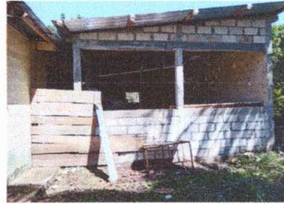
Foto 2: Se observa las puertas, ventanas y balcones de preprimaria muy abierto, la medicion es 0.86 x 2 mts. De dos puertas una ventana la medida es 0.80x 0.85 m. Y dos balcones la medida es 2.25x 1.50 mts.
