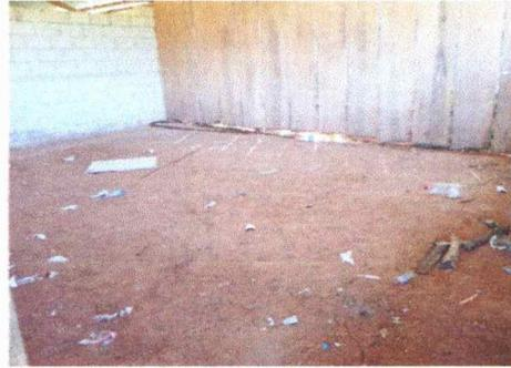
Foto 2: Se observa el piso dentro del aula de primaria de un aula temporal, falta obra gris de piso. Modulo 2
